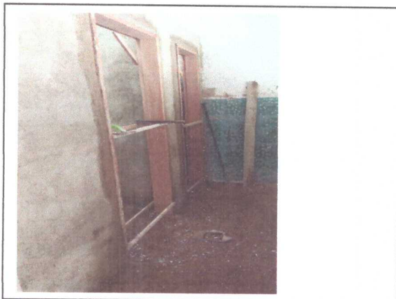
Colocação de caixonetes
