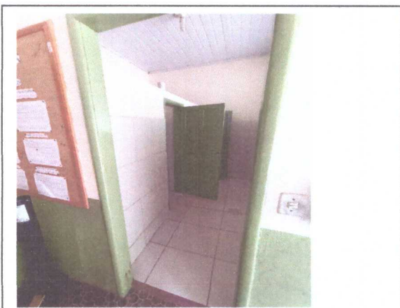
Demolição alvenaria e revestimento (antes)
