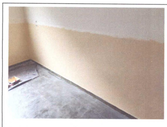
Pintura das salas
