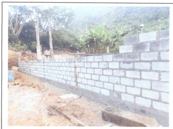
Execução da alvenaria do muro frontal
