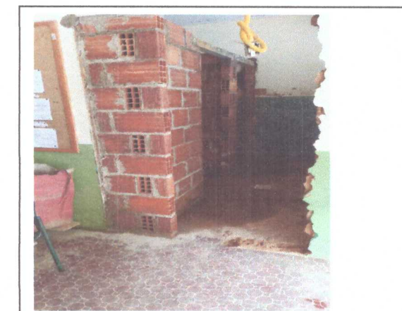
Demolição e execução de nova alvenaria para ampliação do banheiro
