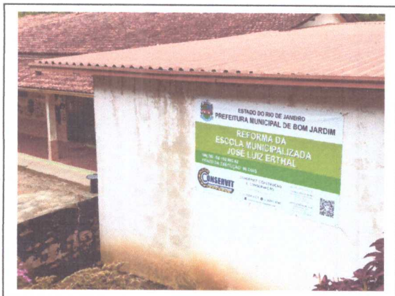
Placa de obra
